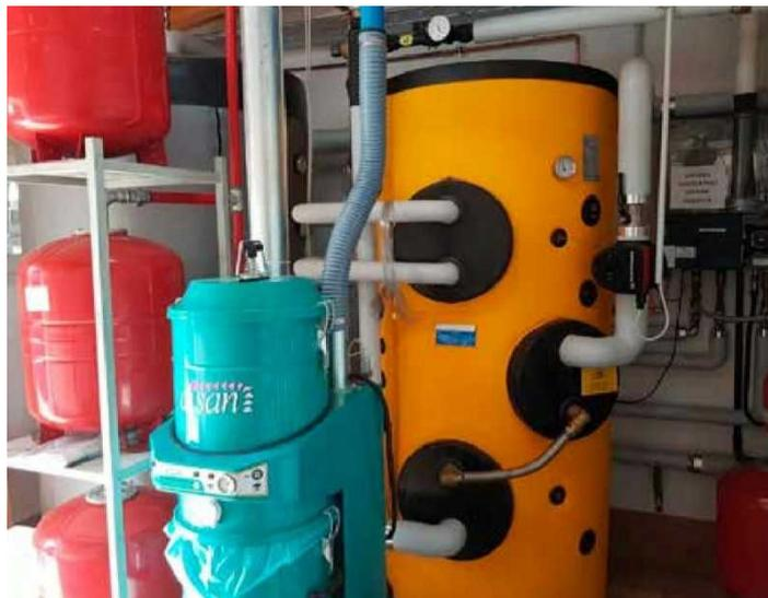
Il generatore installato, una **caldaia a cippato di 349 kW**, alimenta:
